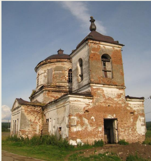
Николаевская церковь с. Большой Кемчуг
